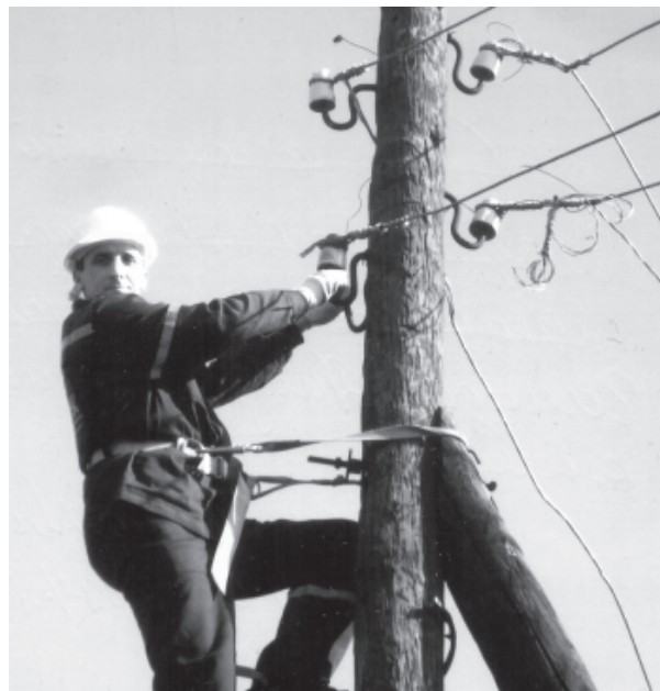
Даир Гъамидов ремонтдин кваллахдик
